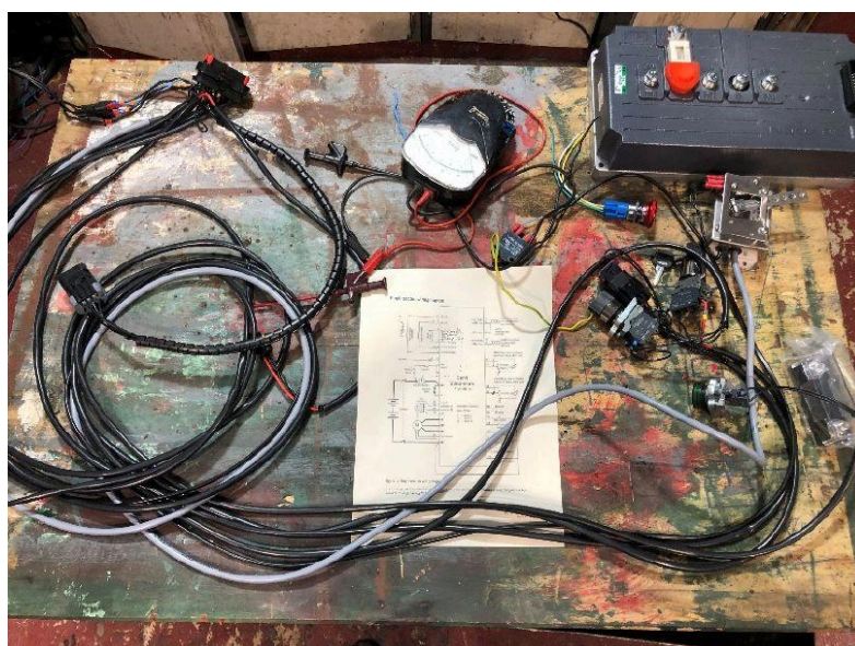
Vue de l'installation des câblages sur le Tracteur-Re
