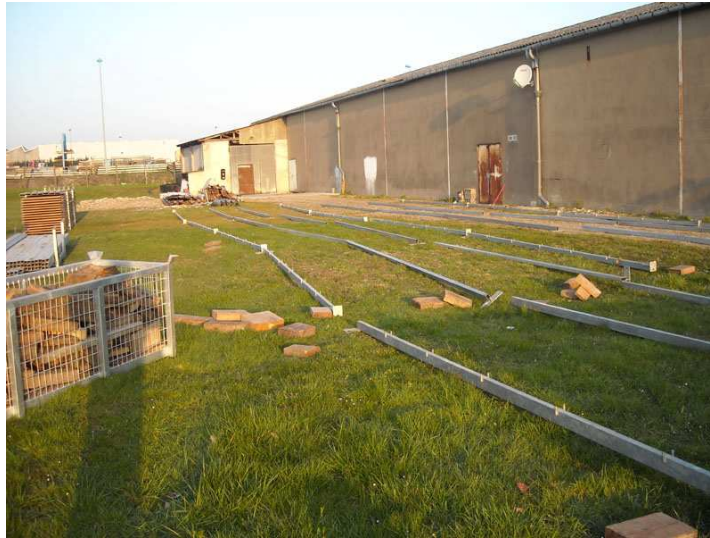
Fig. 2.3. Calage du plancher du chapiteau.
