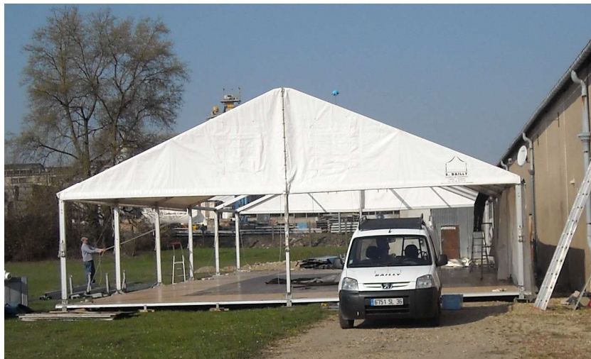
Fig. 2.4. Montage de la structure et de la toile du chapiteau.
